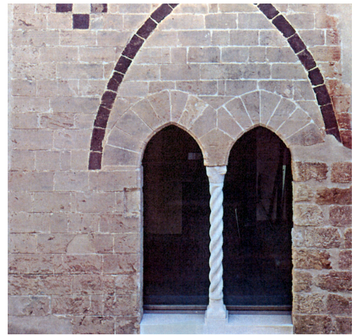
Fig. 6 Bifora superstite con arco acuto in pietra lavica lungo la facciata laterale del Palazzo Castrone Santa Ninfa nel Vicolo dello Zingaro
